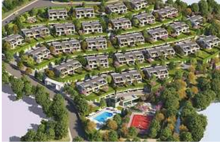
Dekar Uskumru Köy & Zeketiyyaköy Kazı Dolgu Altyapı Teknik Altyapı ve Çevre Düzenleme İşleri
