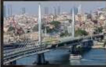
2014 HALIÇ METRO KÖPRÜSÜ
